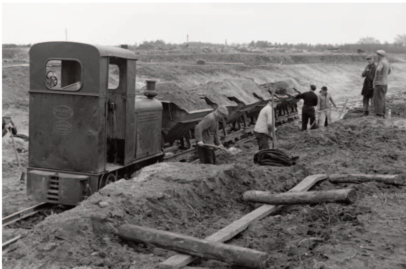
I april 1946 arbejdes der med anlæggelsen af den nye cykelbane ved Gl. Vardevej, hvor der skulle flyttes flere tusind tons jord. Man håbede, at arbejdet ville være færdigt til august, men et byggestop kom i vejen. Banen blev først indviet den 8. maj 1949. Den udgravede jord blev benyttet til at etablere kælkebakken i Vognsbølparken. Foto: Paul Bølling. EBA 40348-008
